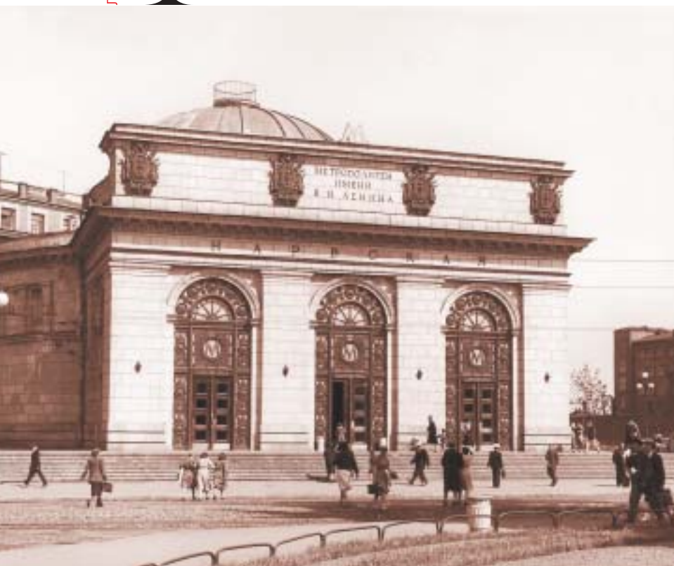
Станция метро "Нарвская". 1955 г. Авторы: Народный архитектор СССР С.Б. Сперанский, Заслуженные архитекторы России А.В. Васильев, Д.С. Гольдгор
