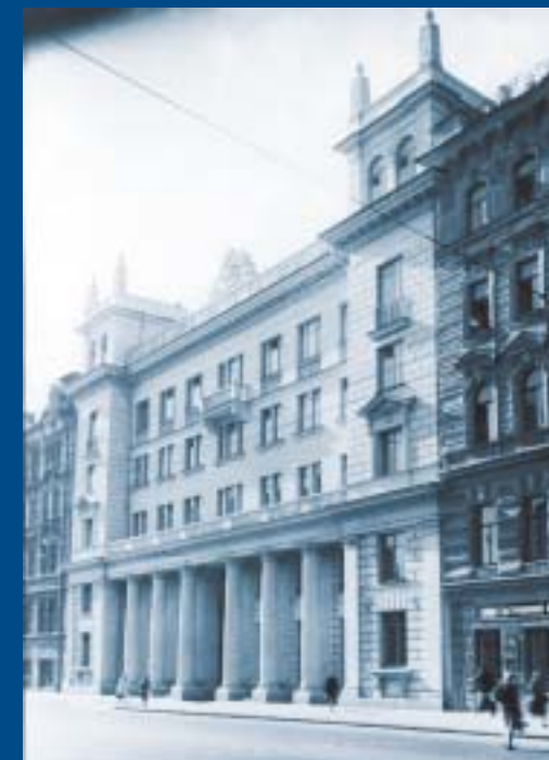
Жилой дом на Невском проспекте. 1955 г. Авторы: архитекторы В.Ф. Белов, Е.М. Лавровская
