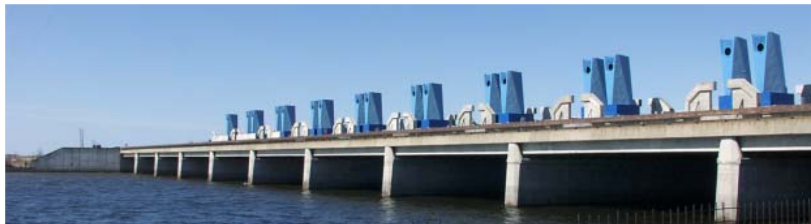
Архитектура "Комплекса защитных сооружений от наводнений". Начало строительства - 1979 г. Авторы: Народный архитектор СССР А.В. Жук, архитектор В.М. Фрайфельд, конструктор С.А. Львов, инженеры А.В. Белевич, В.Г. Иванов
