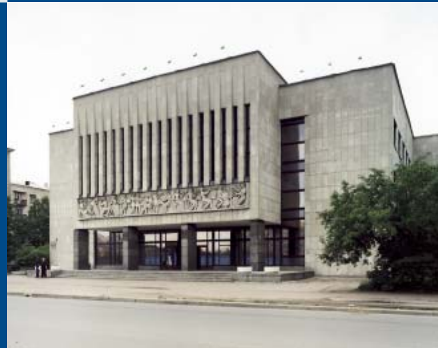
Музыкальная школа на Варшавской улице. 1969 г. Авторы: Народный архитектор России В.В. Попов, архитекторы Ю.Ф. Кожин А.И. Эфраимович
